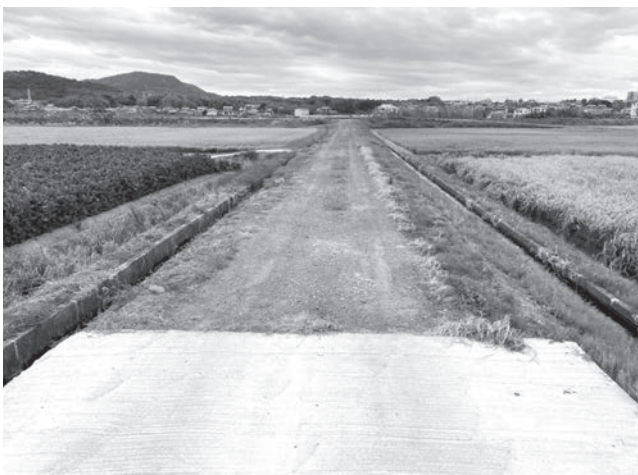
地域住民の共同作業で順次舗装している市道
