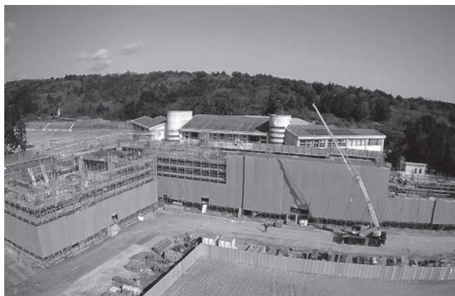
「志成学園」の建設中の様子。 今後も公共施設の改修等が計画されています
