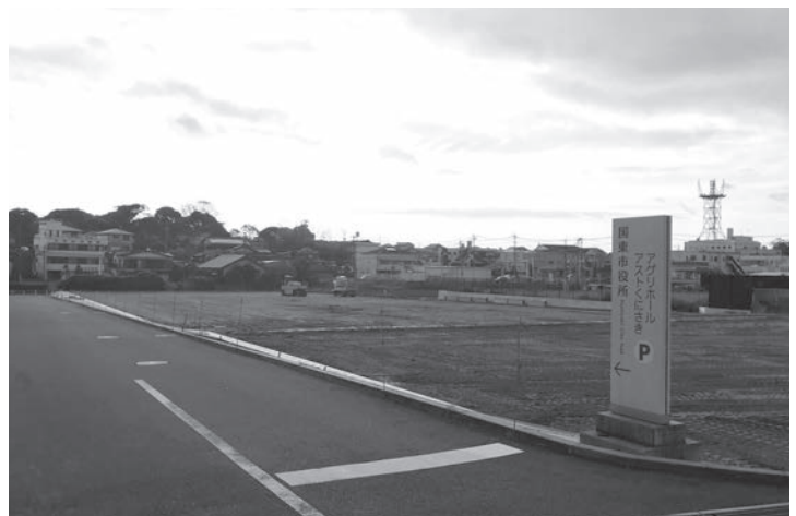
拡張工事中のアストくにさき駐車場
